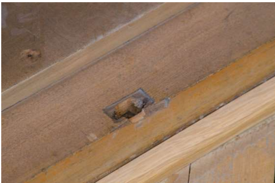
Detail vylomeného zapadacího plechu
