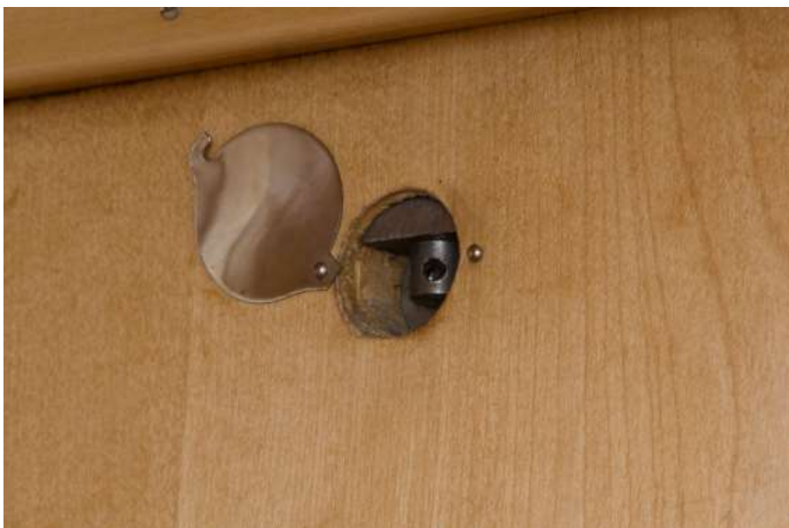
Detail mechanismu ukotvení skříní
