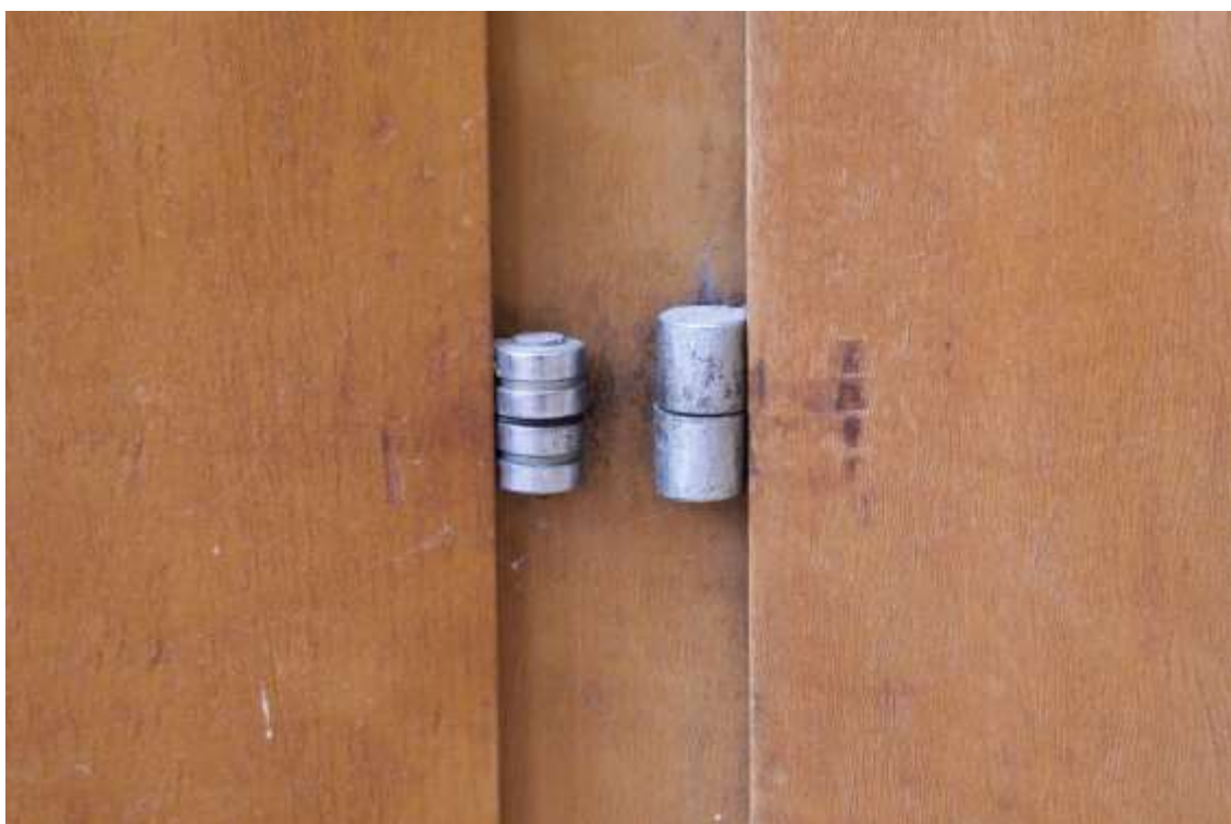
Detail nahrazených závěsů a otlačenin dveří od závěsů dveří
