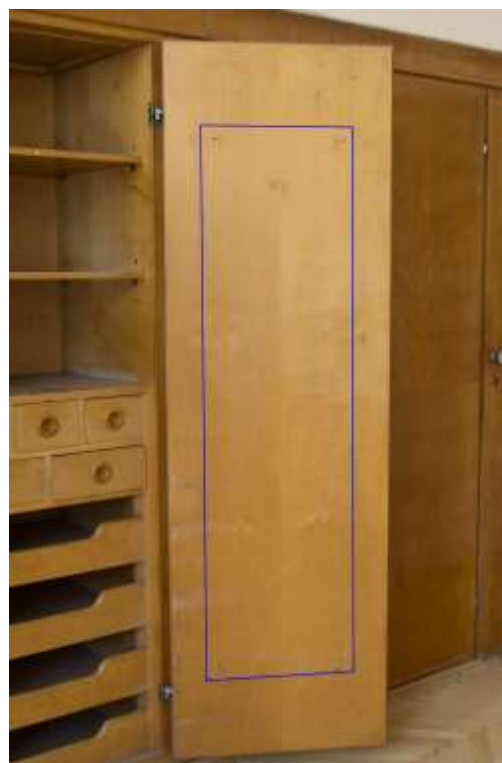
Dílec č. 3, modře označené chybějící zrcadlo
