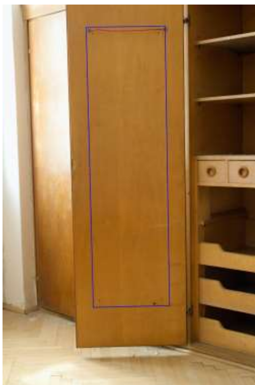
Dílec č. 2, modře označené chybějící zrcadlo
