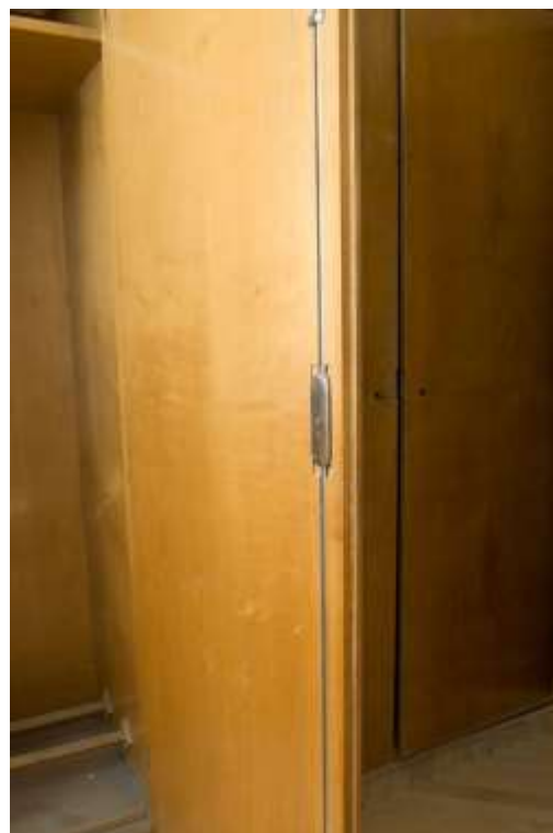
Vyměněný rozvorný zámek v 1. skříni
