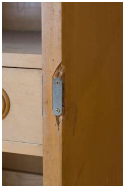
Detail vylomeného zapadacího plechu a sekundární oprava
