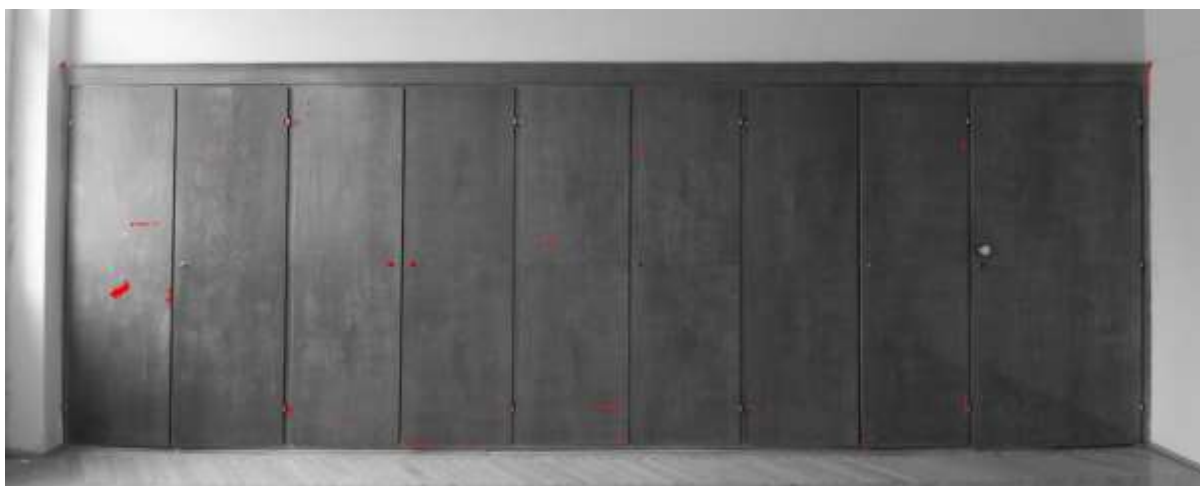
Mapa poškození vestavěné skříně
