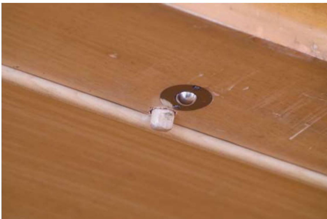
Detail zapadacího mechanismu výklopných dvířek ve 4. dílci
